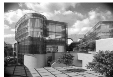
Anekdote – Er was een gelocaliseerde brand voordat het gebouw werd geopend, resulterend in permanente vervormingen. Gebouw in gebruik genomen na vervanging van de beschadigde kolom.
